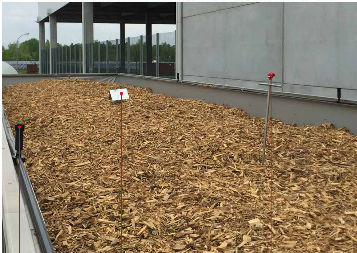
Sistema di irrigazione biofiltro Biofilter-Bewässerungssystem
