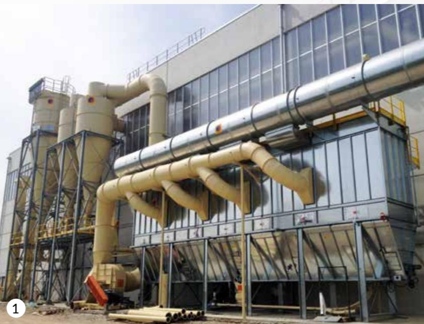
**1** Impianto di aspirazione e filtrazione polveri abrasive derivanti da produzione di pannelli MDF con filtro-ciclone ATEX, cicloni decantatori e filtro a maniche autopulente ATEX. Realizzazione con materiali antiusura. Filtro a maniche con scarico centrale del materiale in valvola a stella ATEX
