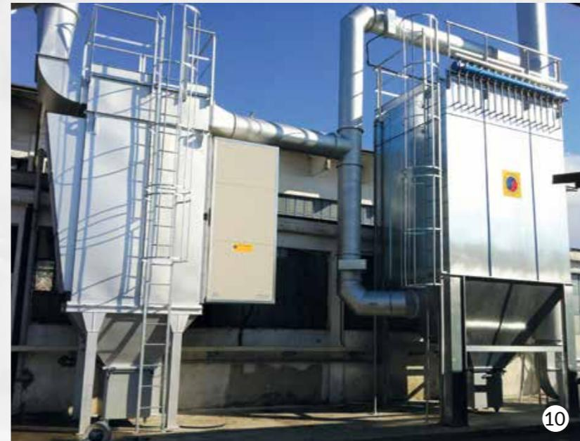
6 Impianto di trattamento polveri da fumi di combustione con depuratore multiciclonico e filtro a maniche per fumi
