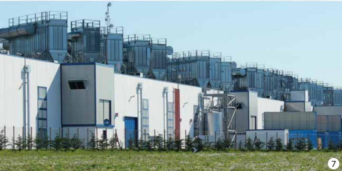
**7** Serie di filtri a maniche modulari autopulenti per grandi impianti di aspirazione e filtrazione
