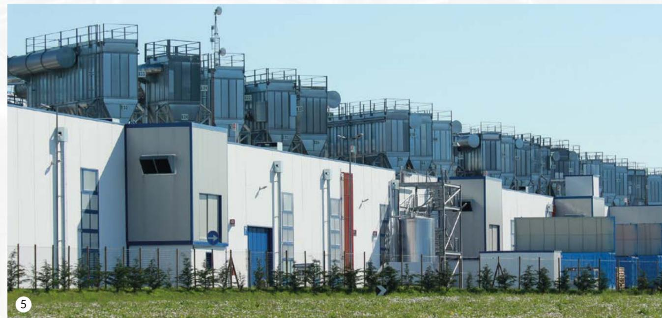
5 Serie di filtri a maniche modulari autopulenti per grandi impianti di aspirazione e filtrazione
