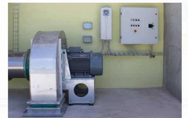
Quadro elettrico per acquisizione segnali di campo ed inverter Electric panel for the acquisition of field data and inverter
