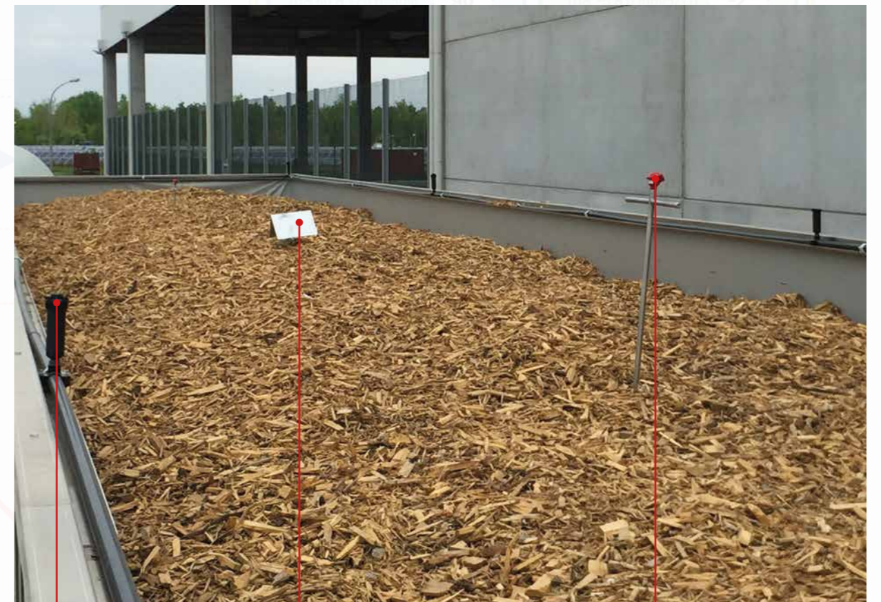
Sistema di irrigazione biofiltro Irrigation system for biofilter
