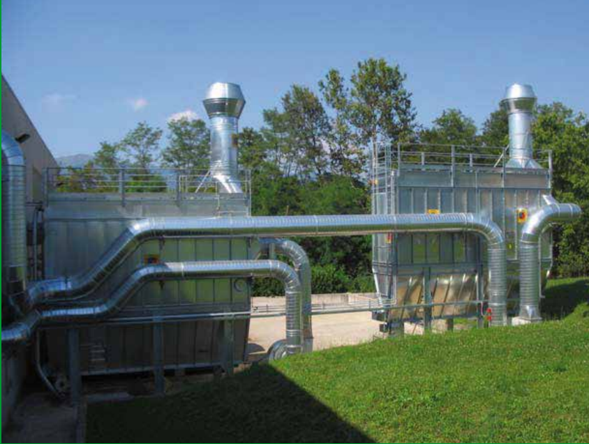
Sistemi di aspirazione su impianti per la produzione di C.D.R.
